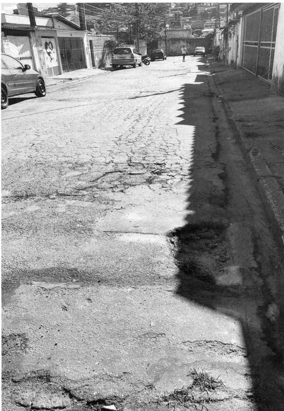
MANUTENÇÃO ASFÁLTICA EM TODA A EXTENSÃO DA TRAVESSA IRACEMA, VILA CINTRA – MOGI DAS CRUZES.
